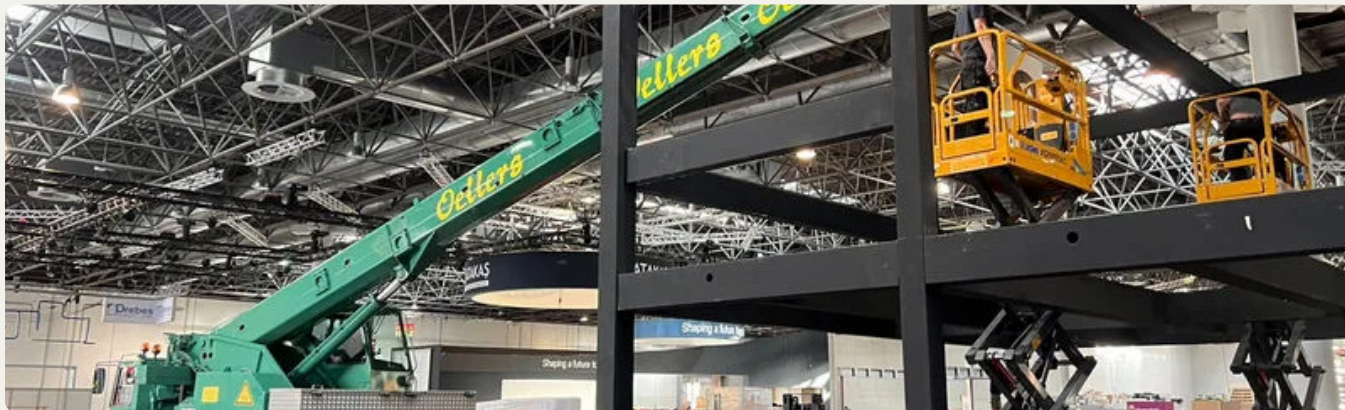
Монтаж в павильоне: сборка строго по проектной документации
