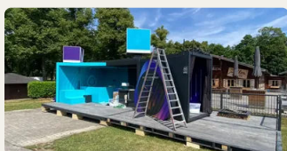
Сборка террасы и надстроечных элементов
