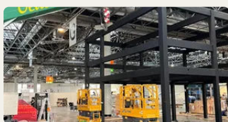
Сетка колонн и балки перекрытия
