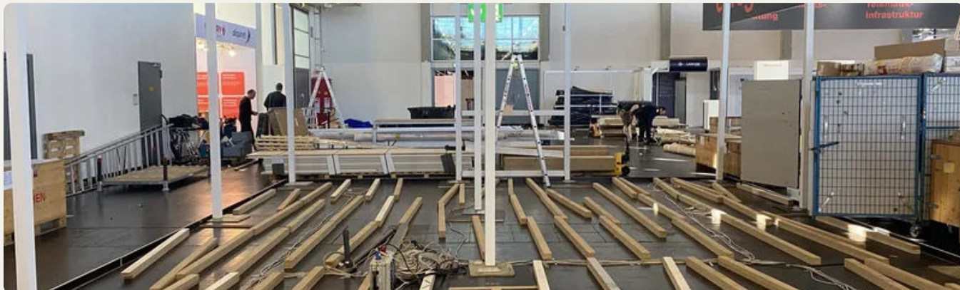
Конструкционный брус разложен на площади стенда
