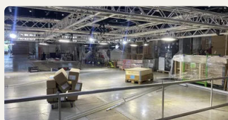
Ферменная конструкция над стендом
