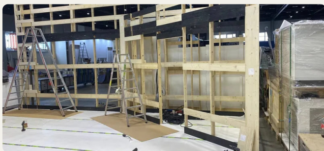
КАРКАС Собранные деревянные рамы, два уровня
