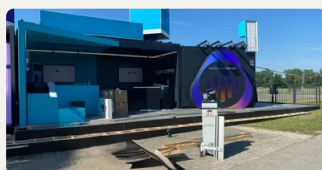
Монтаж техники и прокладка кабеля
