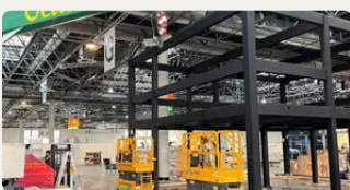
Stützenraster und Deckenträger
