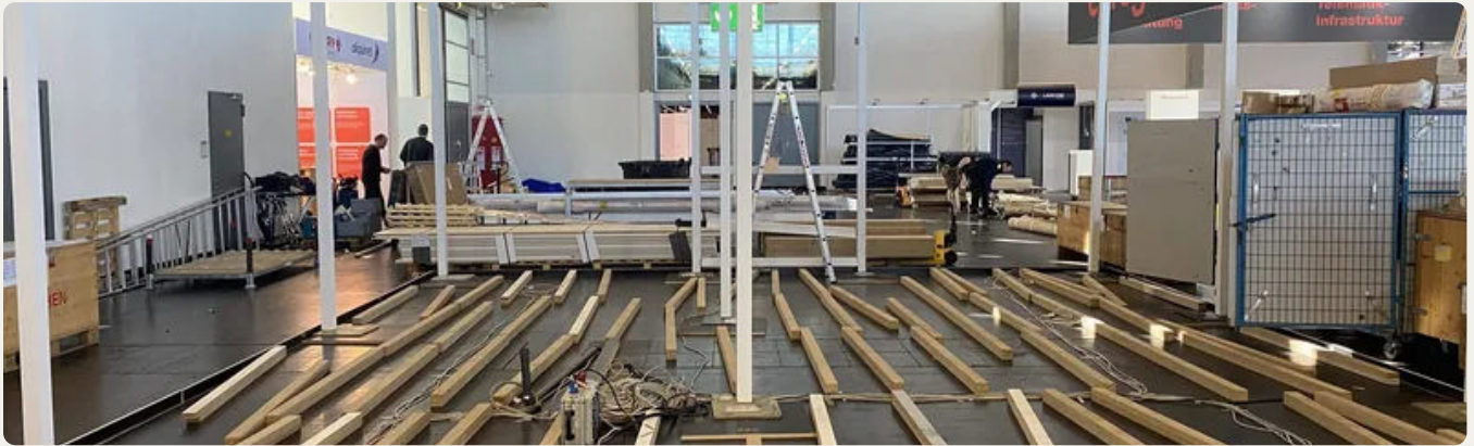
Konstruktionsholz auf der Standfläche vorsortiert
