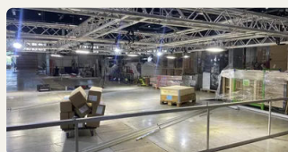
Traversenrig über der Standfläche
