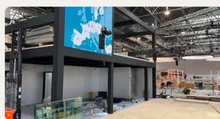
Ausbau: Glaselemente und Großbildschirm
