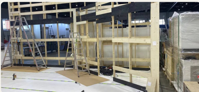
ROHBAU Gestellte Holzrahmen, zweigeschossig
